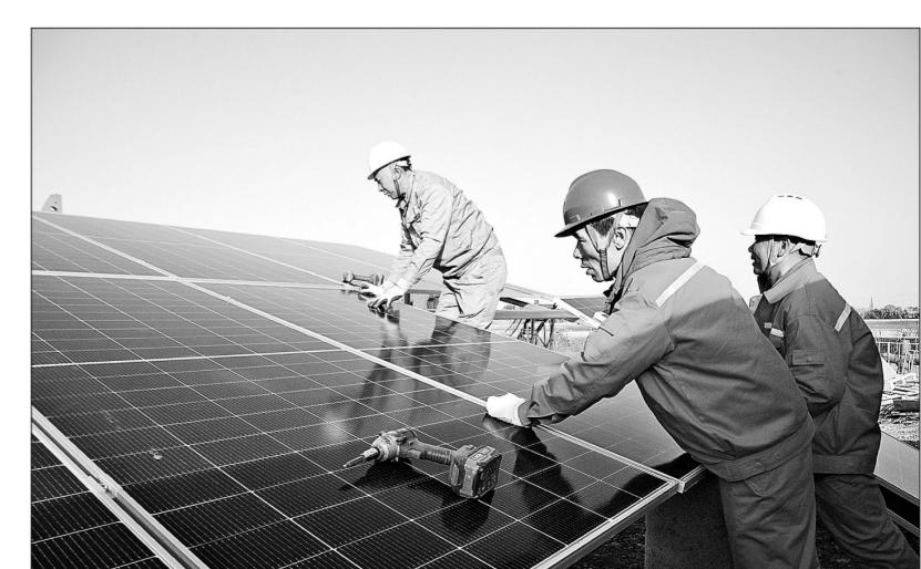
近日,华东油气分公司社区中心锚定绿色能源转型与节能降碳目标,完成边8平台0.3兆瓦光伏项目安装工作。该项目投用后,年发电量可达30万千瓦时,年减少二氧化碳排放20吨,实现经济效益与生态效益双赢。图为社区中心员工安装光伏板。
