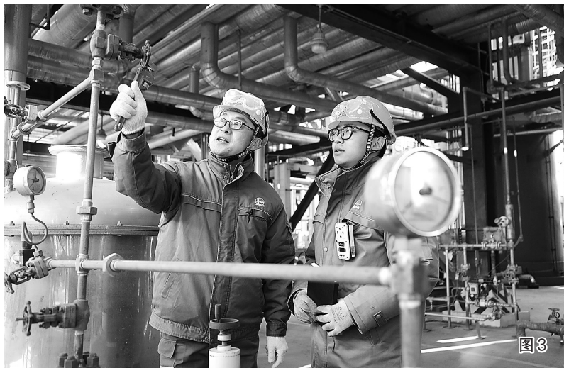
图3:随着气温骤降,齐鲁石化运维中心迅速行动,通过提前置换防冻液、增加值班力量、开展隐患排查等举措扎实做好防冻防凝工作。与此同时,该中心还同步开展员工防冻防凝专项培训,帮助员工掌握各项操作要领,全方位筑牢冬季安全生产根基。图为12月3日,运维中心炼油仪表车间员工置换防冻液。李建强 摄
