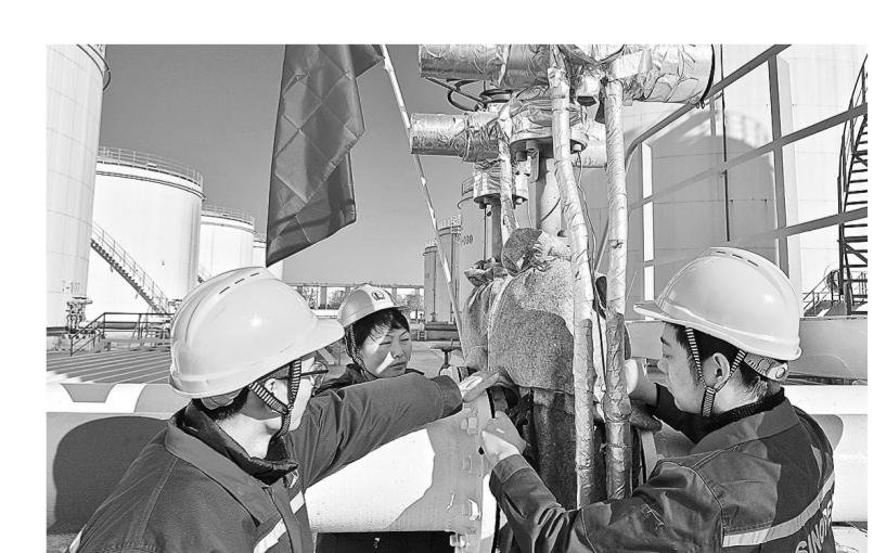
随着近日气温逐渐走低,河南安阳石油围绕汤阴油库冬季运行安全与保供稳定需求,开展专项防寒保障行动,组织人员全面排查油库设备设施,重点检查输油管线、泵阀、消火栓等关键设备,全力确保油库冬季安全平稳运行。图为日前汤阴油库员工进行设备保温防寒工作。
