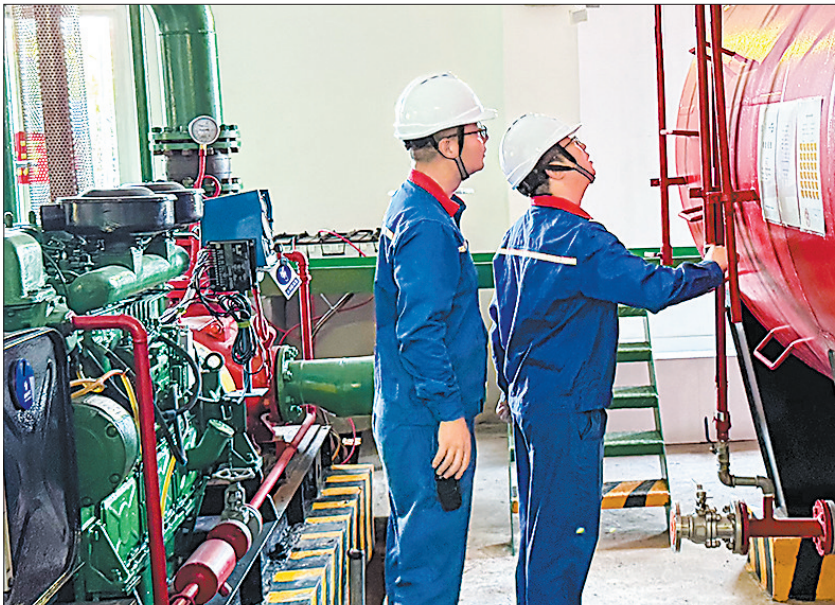
福建石油深入开展安全隐患排查整治“雷霆行动”,强化全员隐患排查治理,确保库站冬季安全平稳运行。图为近日漳州石油铜陵油库组织员工对消防泡沫系统进行检查,确保设备状态良好。 王鸿儒 摄
