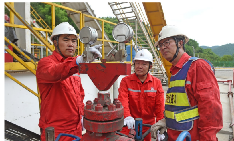
江汉油田涪陵页岩气田员工在钻井施工现场检查。
