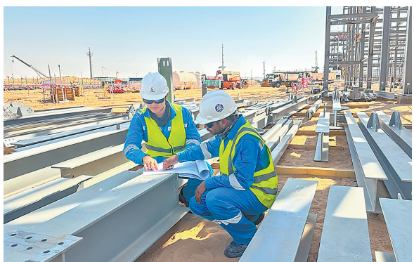
图为十建公司员工对数字化管理平台统计的工程量开展现场比对,确保提升钢结构安装施工效率。 唐铭 摄
