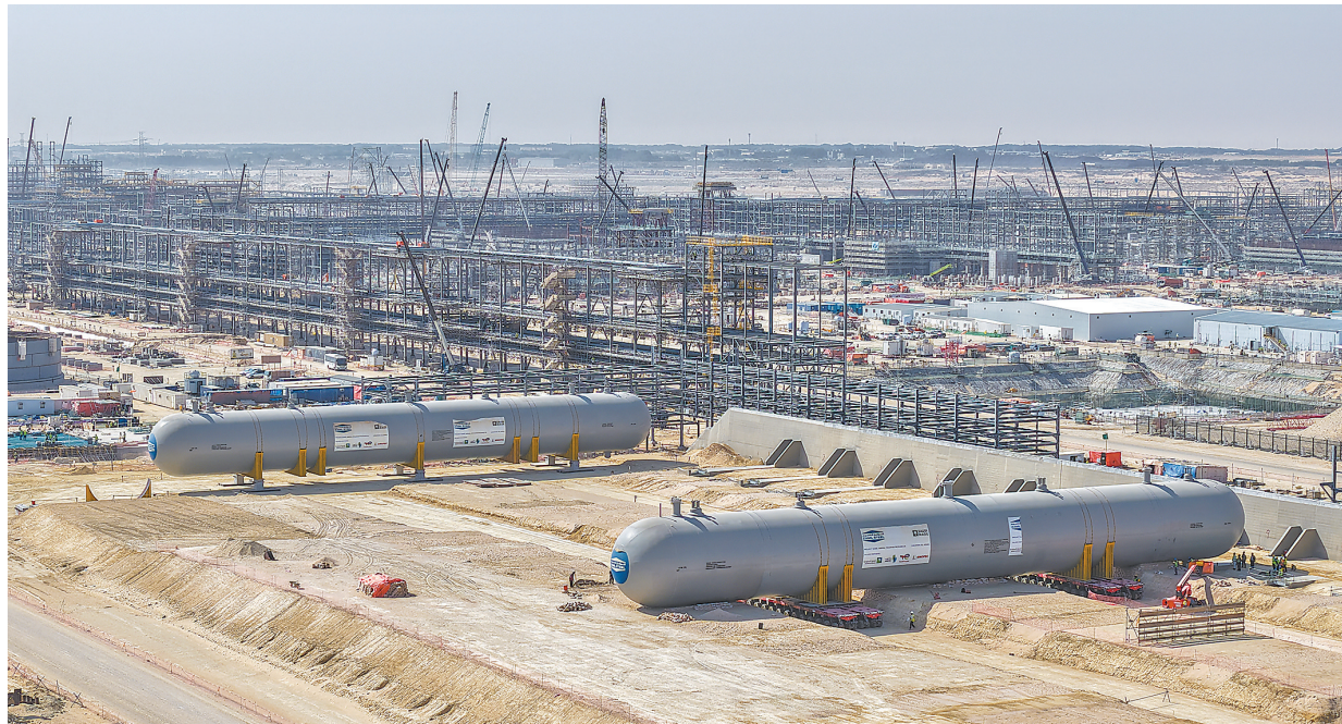
图为南京工程公司沙特 Amiral 项目施工现场。 郑思远 摄
