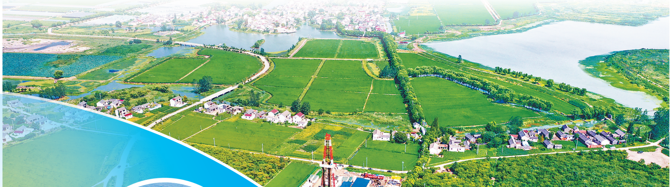
石油工程公司在江苏油田花顶4-11HF井施工作业现场。
