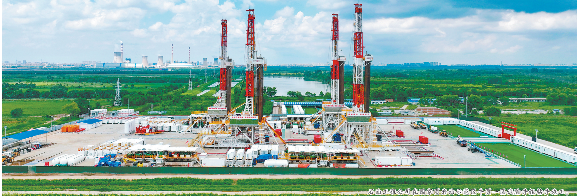
石油工程公司在国家页岩油示范区中顶一区试验井组钻井施工。
