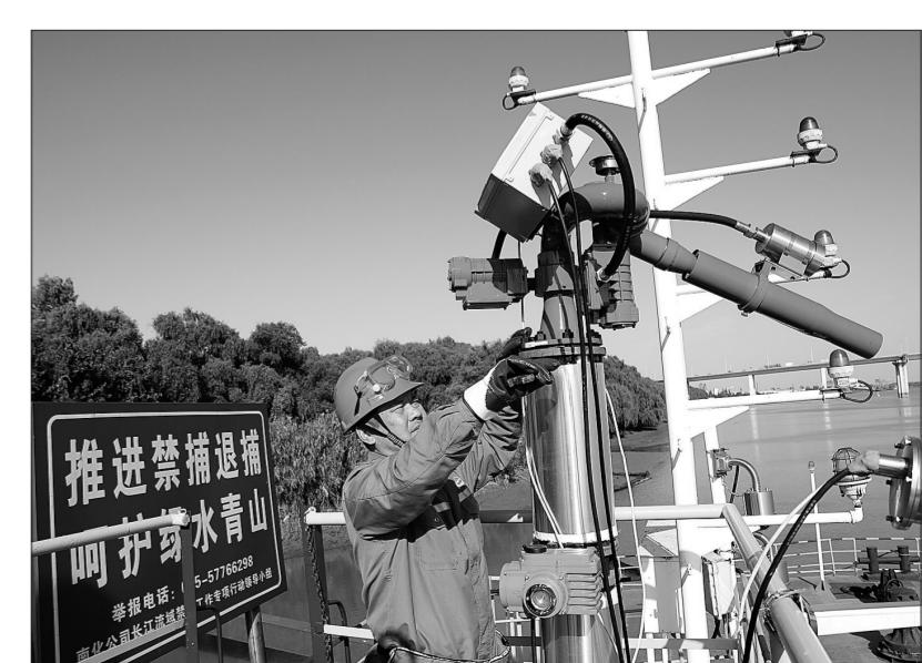
近日,南化公司完成11号码头趸船消防系统智能化升级改造。新增消防炮塔、自动灭火装置等设备,将原有手动消防炮升级为智能系统,构建现代化消防体系,提升应急响应效率,筑牢“技防+人防”安全屏障。图为码头岗位人员检查智能化消防系统。
