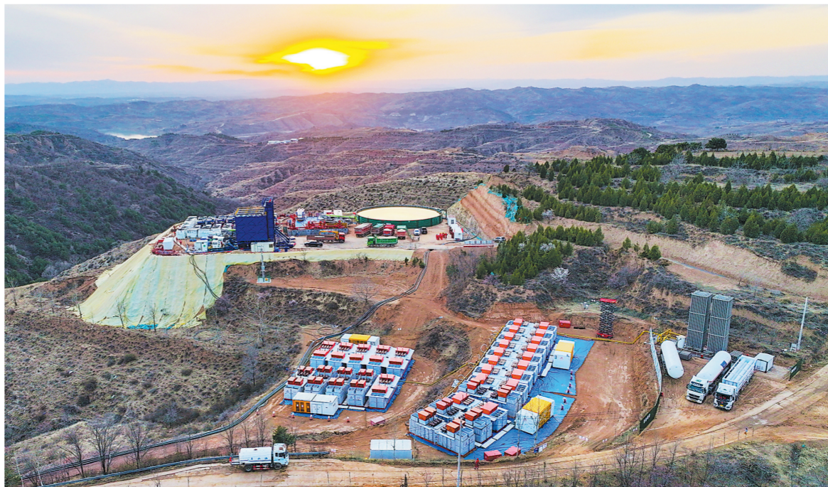
华东石油局在山西晋中区块成功应用“燃气发电+全电动泵储层改造”进行施工。
