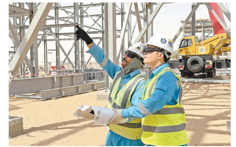
图为维拉查米(左)和刘立超在项目现场研讨钢结构框架施工技术方案。 唐铭 摄
