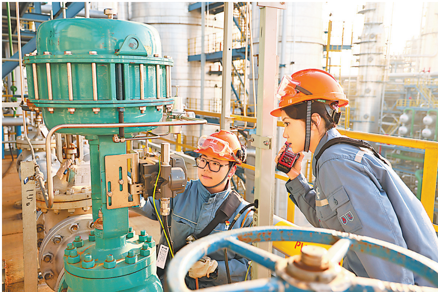
镇海炼化炼油七部催化装置外操员工在核对阀门开度。
