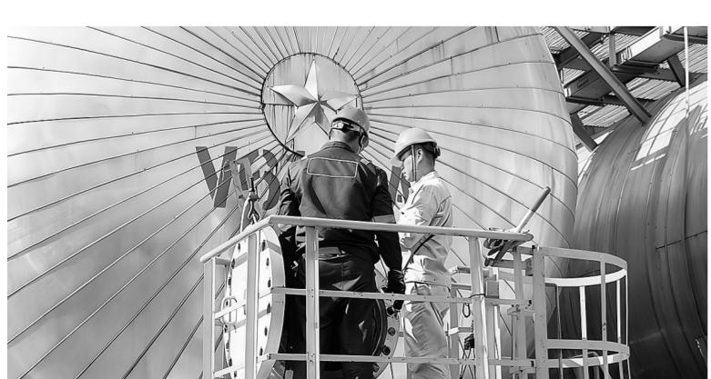
10月23日,镇海炼化千万吨级4号常减压装置检修结果显示,其电脱盐罐沉渣极少、罐壁洁净。这标志着镇海炼化在全国同类装置中首次应用的沉渣冲洗顺控系统取得显著成效。该系统自投用以来,可实现电脱盐罐沉渣冲洗的自动化操作,仅此次检修,就将原本近1个月的清罐时间缩短至5天。图为检修清罐时,工作人员打开电脱盐罐人孔进行检验。徐瑛 摄
