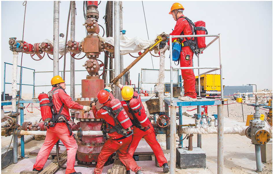
维护班在井口进行油嘴更换维护作业。
