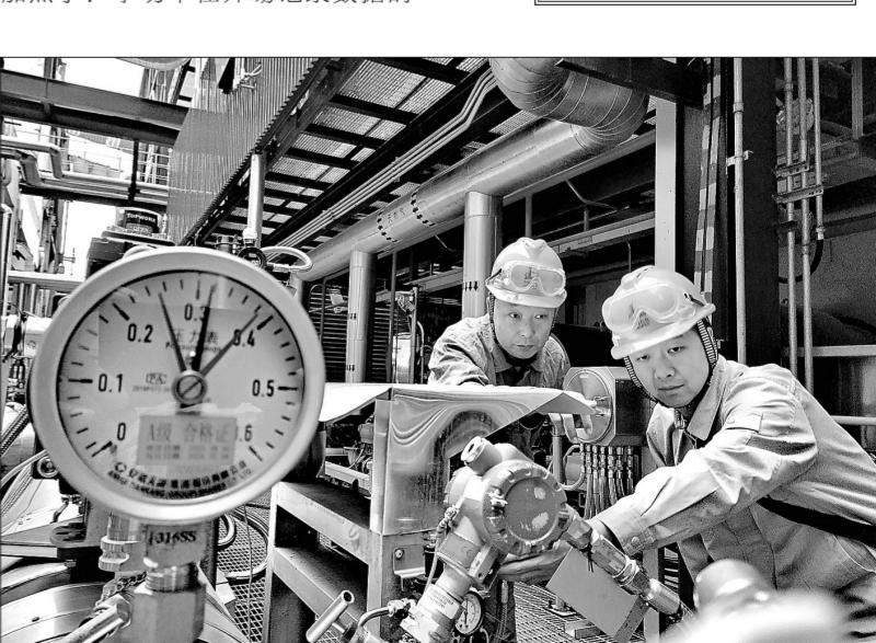
近日,齐鲁石化热电厂结合今冬装置运行实际,提前制定防冻防凝方案及防冻防凝隐患排查表,落实问题描述、整改时间、责任单位等内容,深入开展隐患排查整改,筑牢冬季安全生产防线。图为10月17日检修车间员工检查天然气炉仪表伴热设施。
