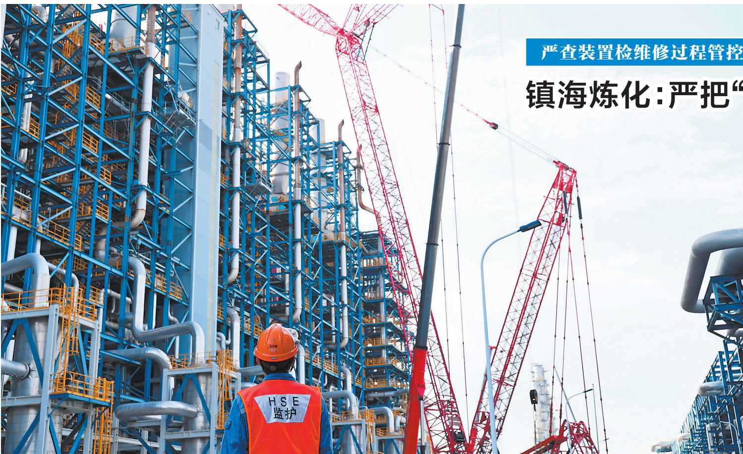
在镇海炼化120万吨/年乙烯装置检修现场,作业安全监护人现场监护乙烯裂解炉网组吊装作业。
