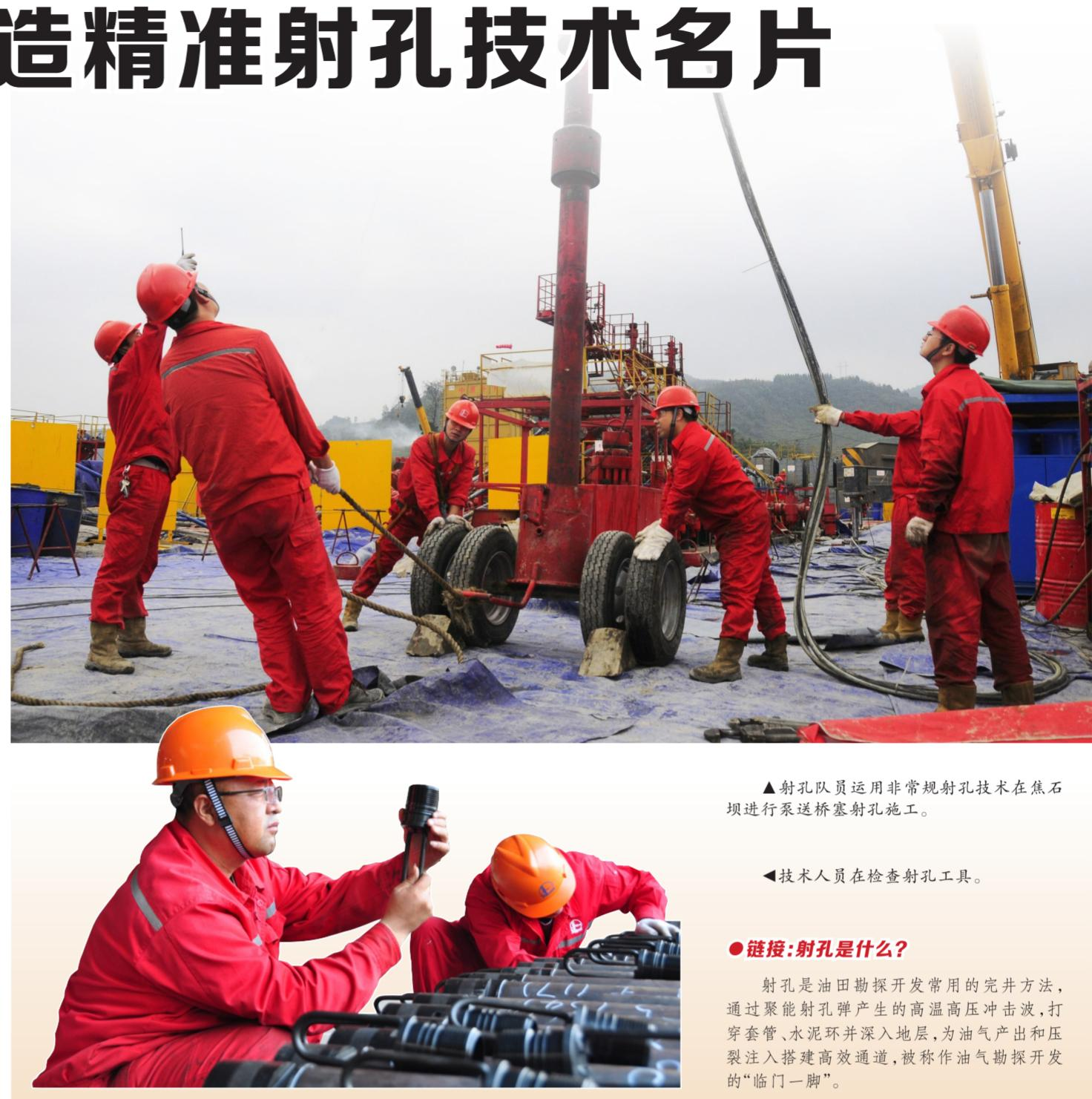
▲射孔队员运用非常规射孔技术在焦石坝进行泵送桥塞射孔施工。
