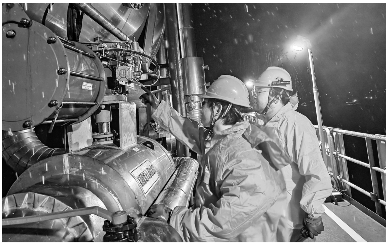
雨夜巡检保障安全生产
