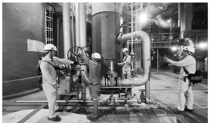
近日,茂名石化重油芳烃部重整区顺利完成脱氮罐切换作业,以标准化操作确保新罐一次投用成功。作业过程中,现场团队严格执行安全三级确认和唱票程序,保障切换作业安全高效推进,为公司增产汽油提供关键工艺支持。图为脱氮罐工艺阀门切换作业现场。 陈解贤 摄
