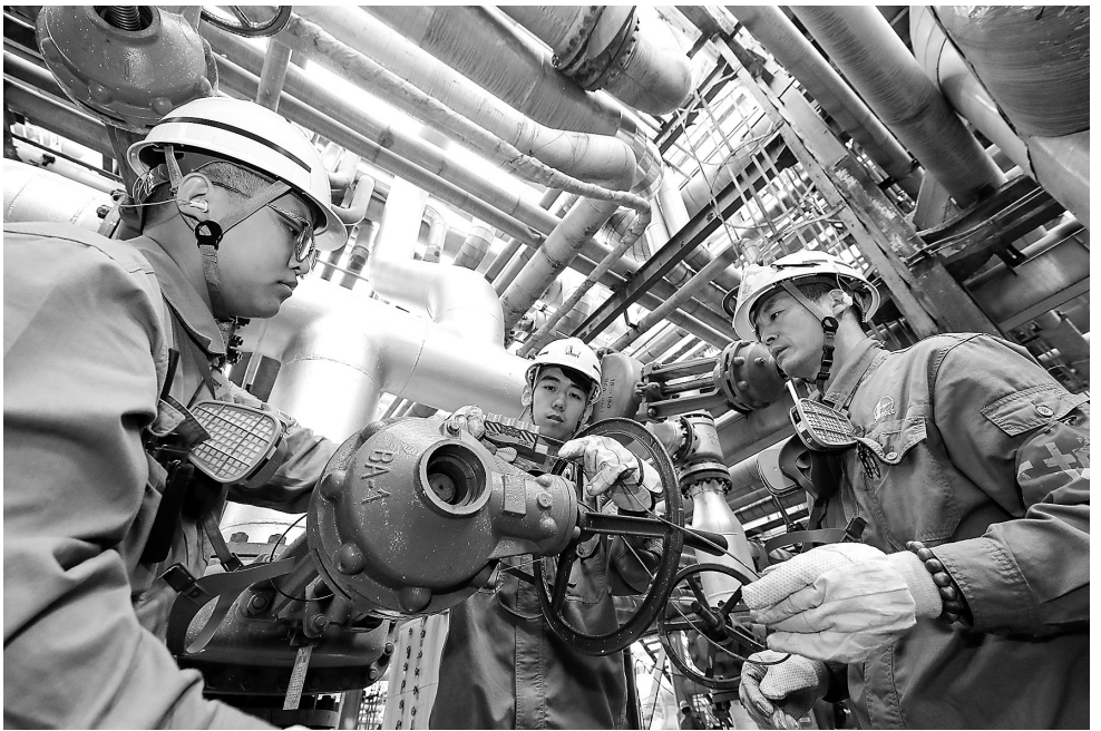
燕山石化构建“四位一体”安全监督体系,邀请第三方专业机构与公司、属地、承包商形成监督合力,管控装置检修过程。图为炼油厂二制氢装置岗位员工在盲板施工作业前对相关阀门进行能量隔离,上锁挂牌。李 雪 摄 支咪咪 张玉凤 文
