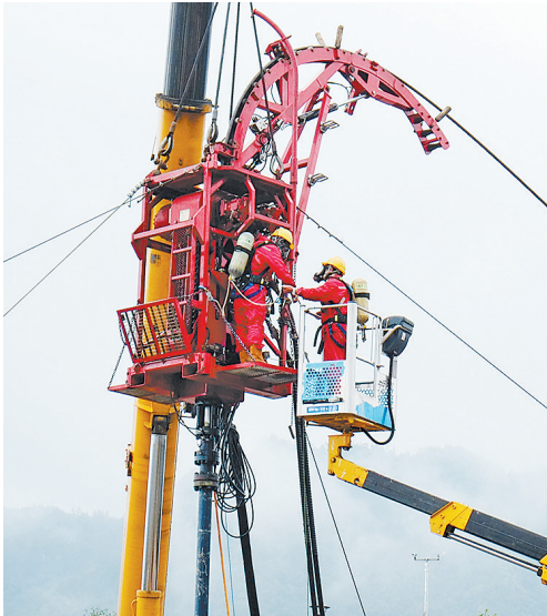
9月2日,中原石油工程井下特种作业公司LY2262V队在普光气田普陆11井检修注入头。 鲁红周 摄
