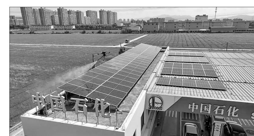
近日,浙江石油在宁波福南加能站率先引入无人机清洁技术,完成该站屋顶光伏板自动清洗作业。该技术通过无人机搭载专用清洁设备,实现高空喷淋与自主飞行协同作业,具有高效、安全等优势,为大规模光伏发电站的清洁维护提供了智能化解决方案。图为无人机清洗该站光伏板。
