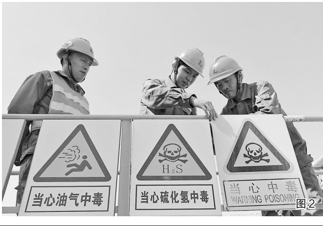
图1:近期,青岛石化通过专业室、作业部、班组三级网格化联动,排查警示标识隐患近千个。在进行跟踪督办、限期整改的同时,他们对排查的隐患实施除锈、更新、加固、涂色、移位等“五定”整改措施,筑牢安全生产防线。图为9月10日,炼油一部员工进行装置警示标识隐患排查。 官鹏摄
