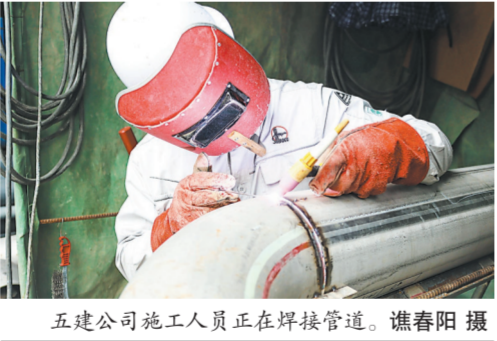
五建公司施工人员正在焊接管道。 湛春阳 摄
