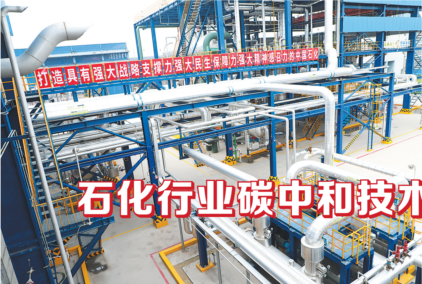
齐鲁石化百万吨级CCUS项目二氧化碳装置。朱作清 摄
