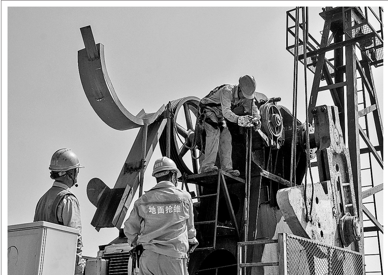
开展危害识别与风险评估 严控高风险作业 中原油田地面工程抢修维修中心针对抽油机安装、井口连接等涉及吊装、登高、动火及用电的高风险作业,全面开展危害识别与风险评估。他们严格落实安全质量标准、作业流程和现场标准化要求,精准识别风险点,有效消除风险源。图为9月4日,该中心文卫服务工区员工按照安全操作规程,安装卫360-59井抽油机。李刚 摄
