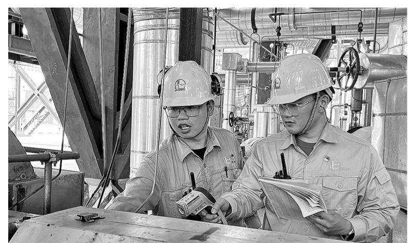
近日,金陵石化化工一部党委组织开展“党员设备百日特护”活动,将12台A级、32台B级动设备作为党员特护设备,由班组党员每班增加两次特护巡检,加强测温、测振、润滑和压力、电流等专项检查。白班管理岗位党员要及时梳理班组上报数据,对比分析潜在风险“开方抓药”,尽快消除各类隐患。图为9月1日,该部净化合成区党支部二班党员对低温甲醇装置的动设备开展特护检查。钱宏跃 摄
