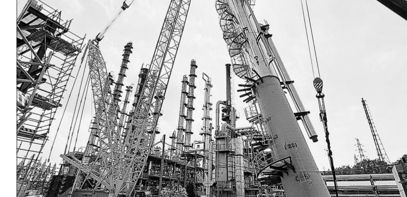
8月29日,南京工程安装分公司承建的金陵石化1号加氢裂化改造项目脱丁烷塔成功吊装。此次吊装场地狭小,项目部吊装团队提前谋划、科学部署,结合现场实际制定吊装方案,对吊车站位进行精准规划,全面检查吊索具、地基承载力、机械工况及应急预案等,实现吊装作业一次成功。图为脱丁烷塔吊装现场。
