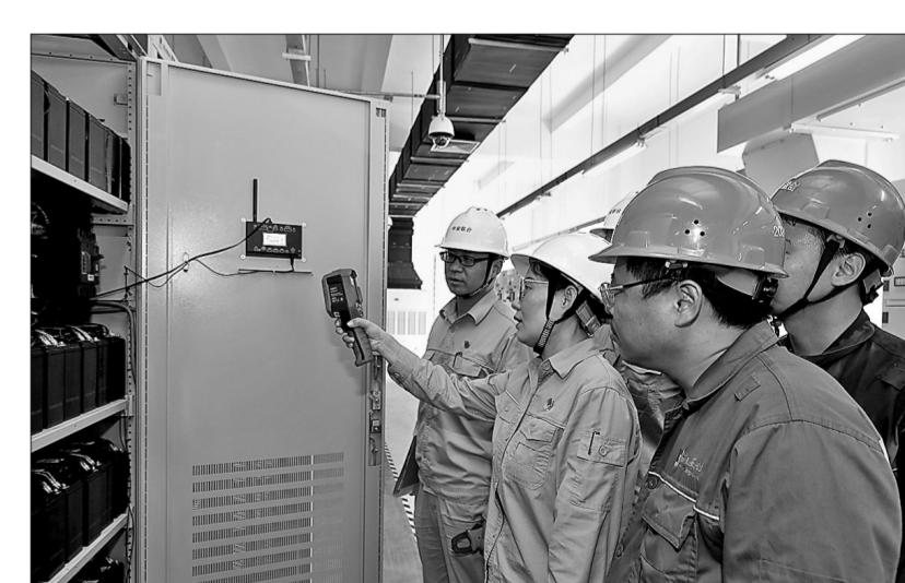
8月21日，新型水系钠离子蓄电池组在中安联合码头罐区10千伏变电所试运行，为中国石化系统内首次应用。作为目前先进的绿色储能设备，该蓄电池组具有绿色无污染、无须通过充放电保持电池活性、易回收等优点，具有广阔的应用场景。此次成功试运行，是中安联合践行绿色发展理念的有力举措。图为电气技术人员对该蓄电池组进行检测。
