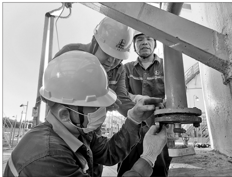
广西北海石油铁山港油库员工在油罐区消防泡沫管线排渣口处安装排渣小装置。 罗远鹏 摄
