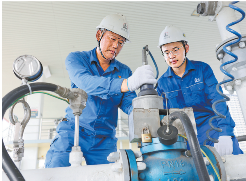
安徽石油加大季节交替时期安全隐患排查力度,采取现场检查和远程督查等方式,加强对库站重点区域、重点部位、重点环节的安全检查,确保生产经营安全平稳运行。图为近日合肥石油油库员工检查静电接地装置。
