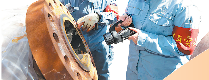
▲济南炼化炼油三部员工认真检查换热器检修质量。
