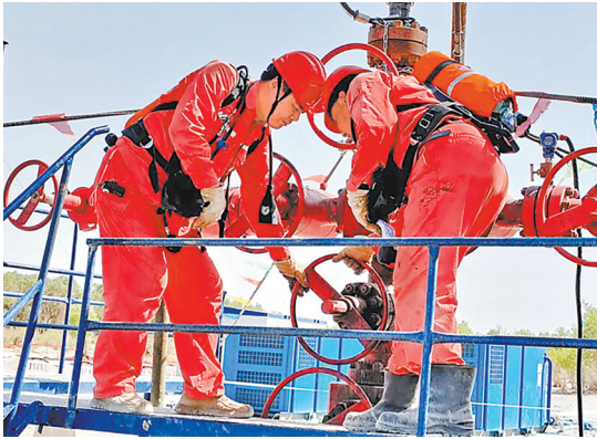
▲河南油田油服中心西部工程服务部员工自主开展油井低压测试作业。 唐勇摄
