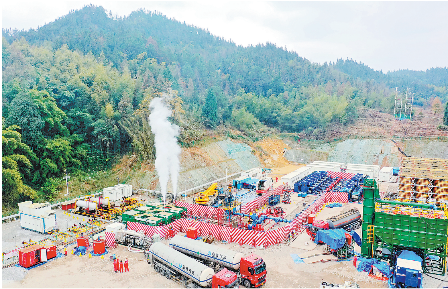
南川常压页岩气田在阳51平台进行注二氧化碳施工。沈志军 摄
