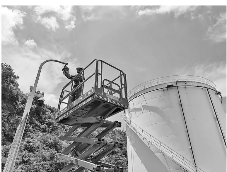
为保障油库夜间作业安全与设备稳定运行,近日,浙江丽水石油莲都油库员工开展登高照明整治行动。他们排查线路老化情况,精准更换30余盏故障灯具并完成线路检修,有效提升了照明系统的稳定性。图为8月8日,员工正在更换灯具。
