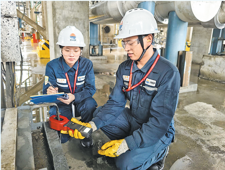
福建联合石化员工根据雷电预警系统信息提示,对关键设备进行防雷接地检查。
