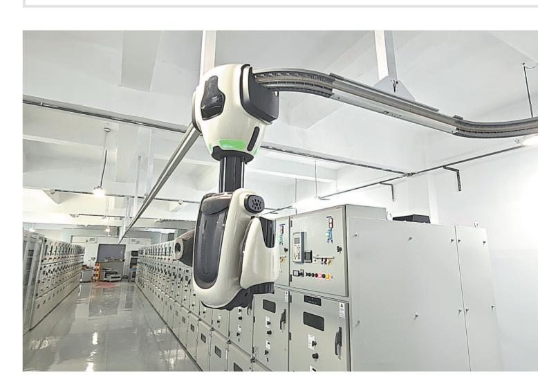
日前,高桥石化在变电站首次投用智能巡检机器人。该机器人采用多种采集设备,对变电站2400多个点位进行检测,通过大数据分析等技术,实现智能巡检、远方作业监护等功能,同时对收集的数据进行神经网络训练,不断提升识别准确率。图为智能巡检机器人巡检现场。
