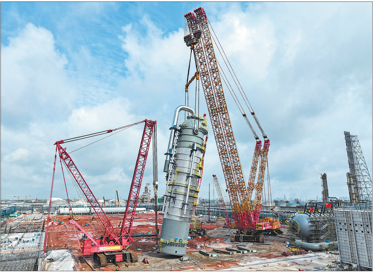
茂名石化升级改造项目1364吨急冷水塔吊装就位
