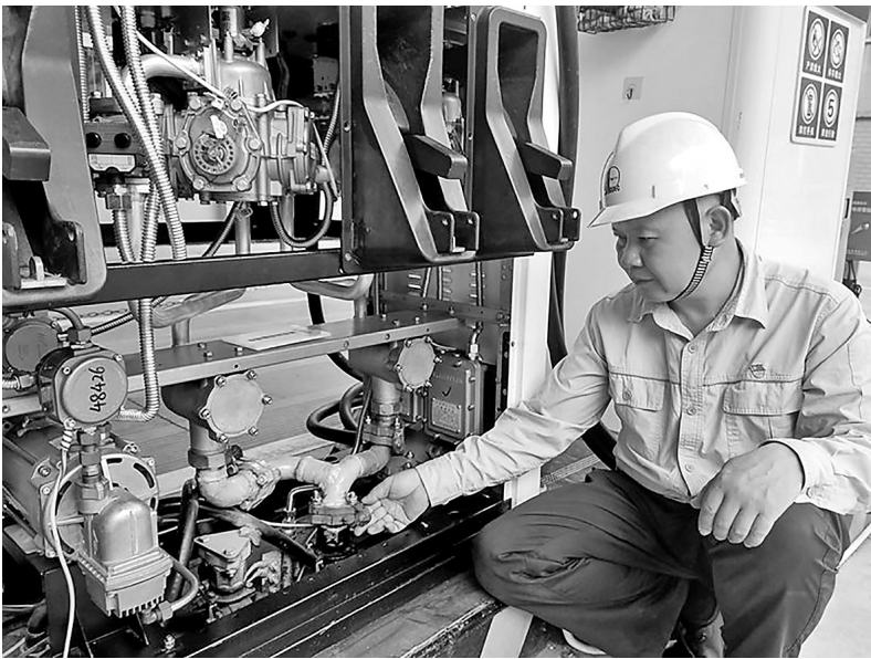
浙江温州石油安全管理员吴思树对加油机内管线加装三通配件。 林廷光 摄
