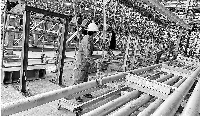
7月26日,十建公司浙江石化工程项目部施工人员运用万向运输车运输安装管束。 孟琦 摄
