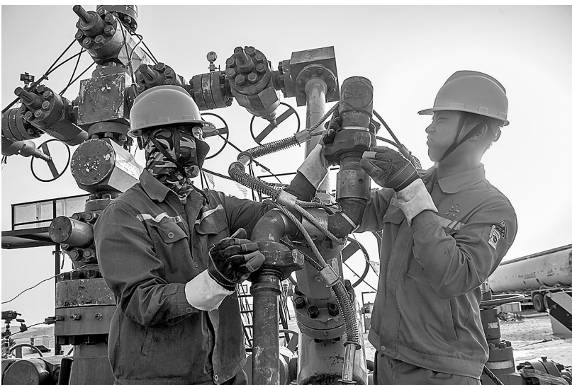
顺北油气田SHZ4-3H井更换新型注气接头后,现场操作人员快速完成注气管线安装任务。 李学仁 摄
