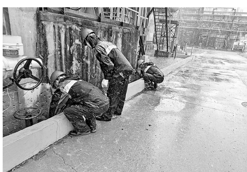
▶7月30日,受第8号台风“竹节草”影响,上海市出现大范围降雨。上海石化全力防台防汛,提前落实防台风防汛措施,排查高空设施风险,消除高空坠物隐患。疏通装置现场雨水明沟、地下管线及污水系统,确保排水畅通。图为操作人员进行清污分流。
