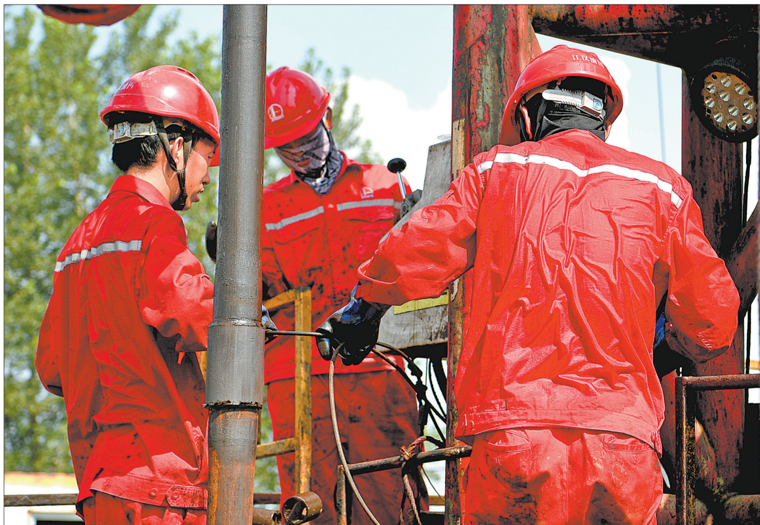
7月以来,湖北多地持续高温,即使避开高温时段,作业现场仍然湿热难耐。7月7日下午,在江汉油田潭761-斜15井作业现场,试油一班员工在烈日下进行起管作业。 宋国梁 摄
