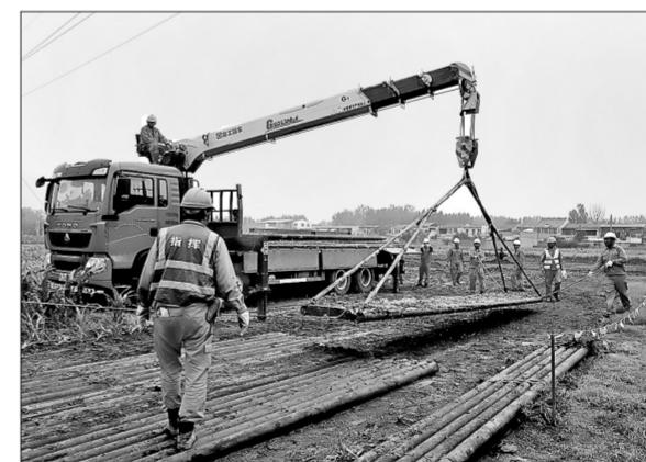
中原石油工程公司工程服务中心秉持“以质量效率换来绩效”理念,在中原区域建立钻前工程、搬迁安、设备维保标准化作业体系。今年以来,完成24口井队搬迁、84口井基础摆放和钻杆排铺设任务,实现单井平均搬迁周期缩短30%,施工效率提升40%,设备利用率达95%,刷新中原工区搬迁运输作业新纪录。图为7月18日,该中心钻前工程大队为新井场铺设钻杆排。徐东 摄
