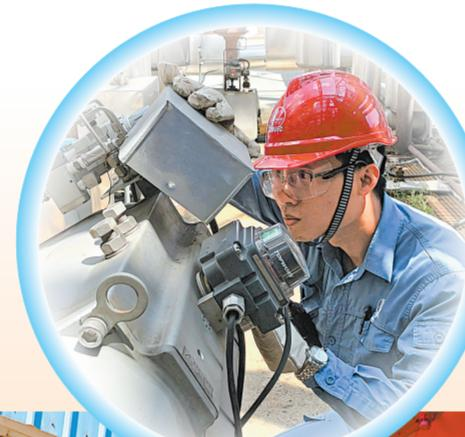
随着气温逐渐上升，上海石化炼油部1号炼油联合装置有序开展装置设备的防护降温工作。图为管理人员检查电磁阀接线盒防雨罩。
