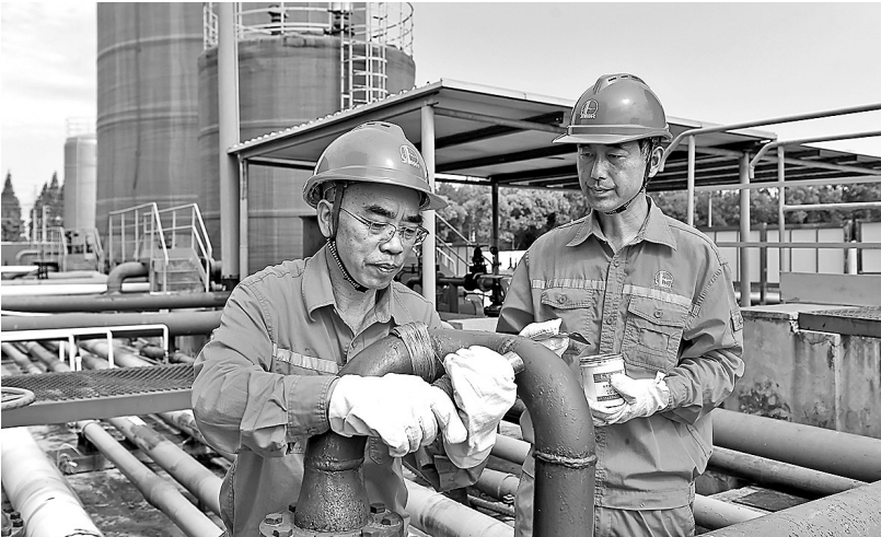
江汉油田技师刘文佩(左)为一处管道漏点进行包扎堵漏。 李东勇 摄
