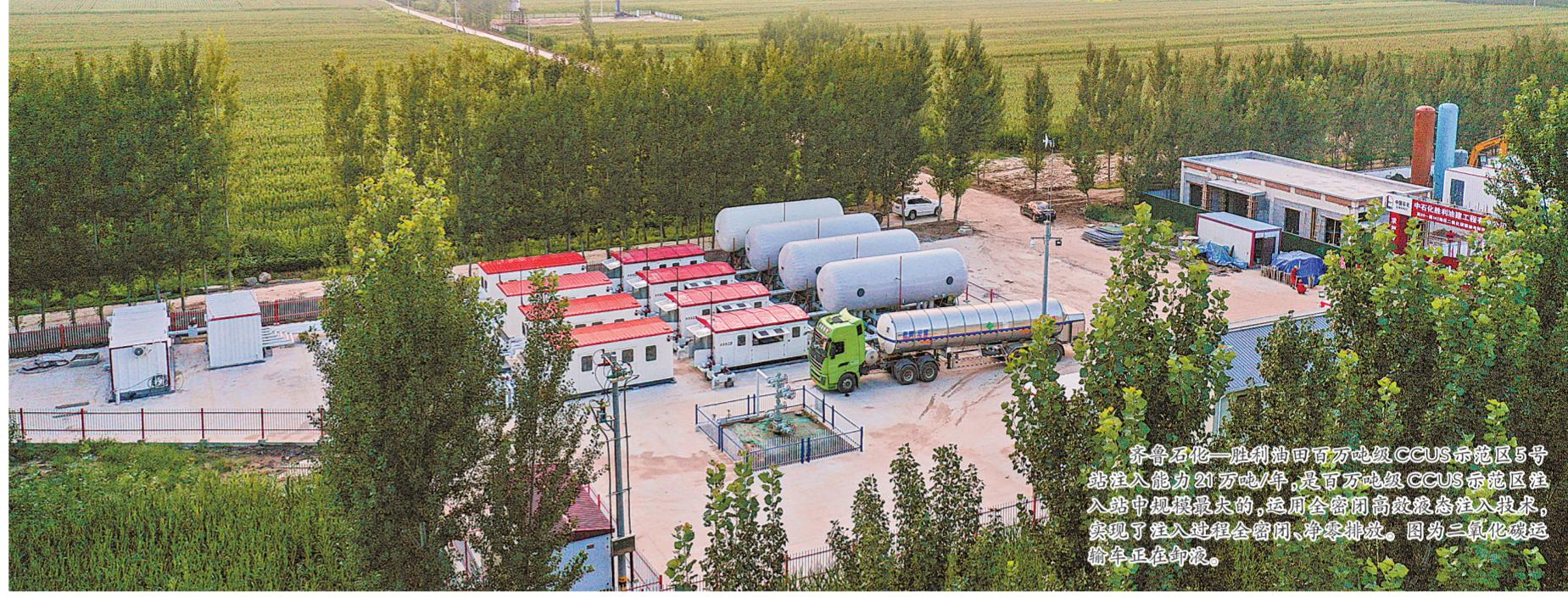
齐鲁石化—胜利油田百万吨级CCUS示范区5号站注入能力21万吨/年,是百万吨级CCUS示范区注入规模最大的,运用全密闭高效泵注入技术,实现了注入过程全密闭、零排放。图为三氯化碳运
