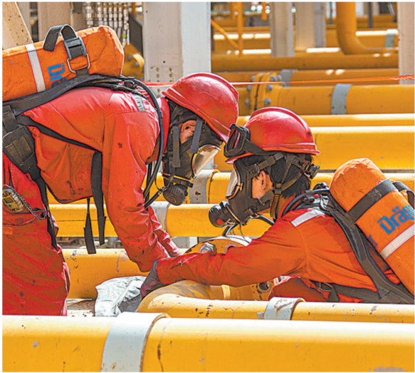
周得崇(右)和付阳佩戴正压式空气呼吸器，在高温下进行阀门拆装操作。
