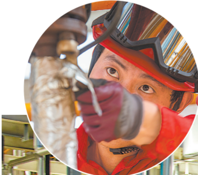
周得崇(右)和付阳佩戴正压式空气呼吸器，在高温下进行阀门拆装操作。
