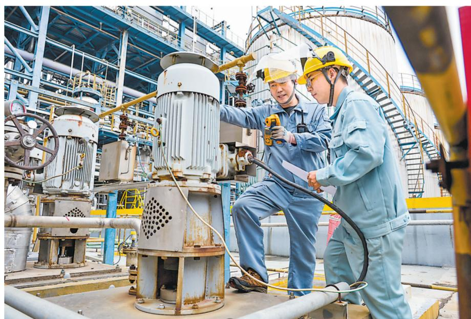
扬子石化利用数智化手段提升装置安全效能,应用润滑油全生命周期健康智能监测系统、腐蚀在线监测系统、泵群状态监测系统等进行数据分析,强化设备安全状态监测,提升装置安全管理水。图为6月23日烷基化装置员工在现场对泵群状态监测系统进行对照检查。
