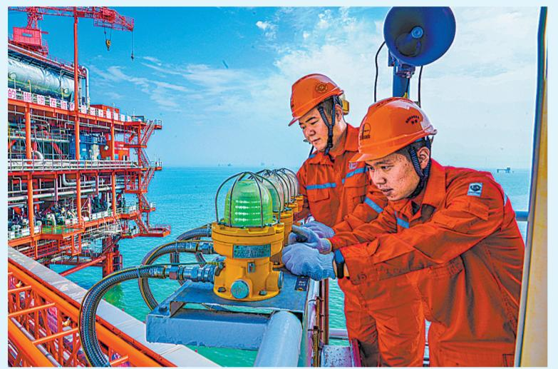
**查:** 胜利油田海洋采油厂开展仪器仪表防爆问题专项排查整改行动,组织海上平台岗位员工对照“低老坏”屡查屡犯问题清单,全面检查电力、工艺、自动化、注采输等系统防爆设备,并及时组织整改,确保海上安全生产。图为6月16日,员工正在查改海上平台防爆设施隐患。 张灿 摄
