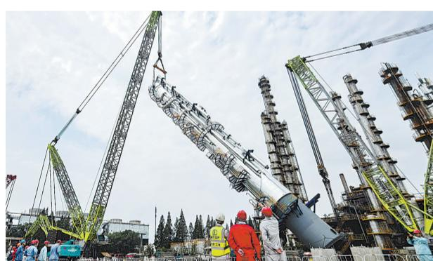
6月11日,南京工程公司承建的金陵石化Ⅰ加氢裂化改造项目现场,南京工程安装分公司完成项目最高设备——T-202塔吊装任务。该塔高67.8米、重325吨,采用“地面模块化预制+整体吊装”模式吊装,有效降低高空作业风险,确保施工安全。图为吊装现场。
