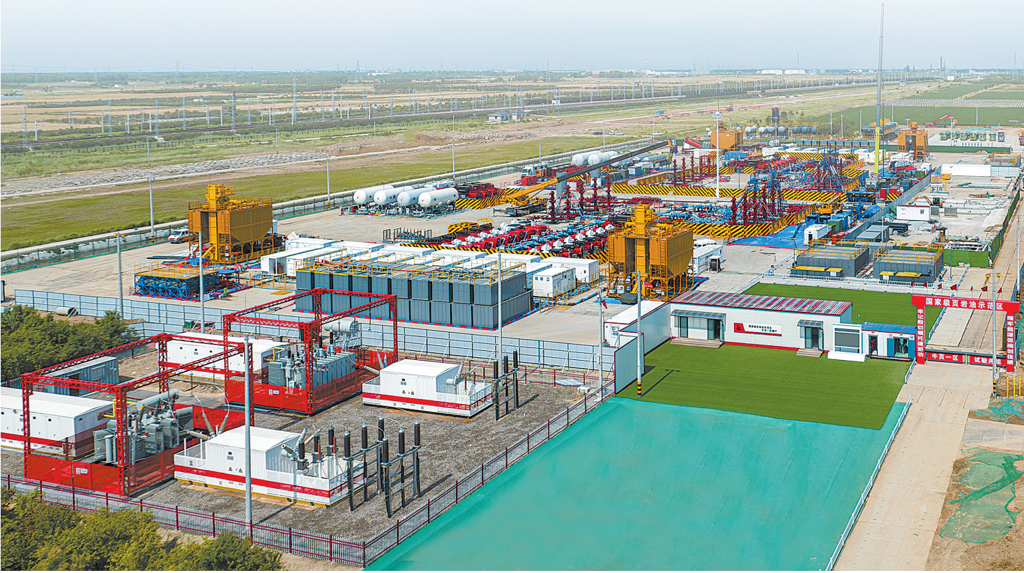
胜利东部油区首个搭配双电驱压裂机组的牛页1试验井组。
