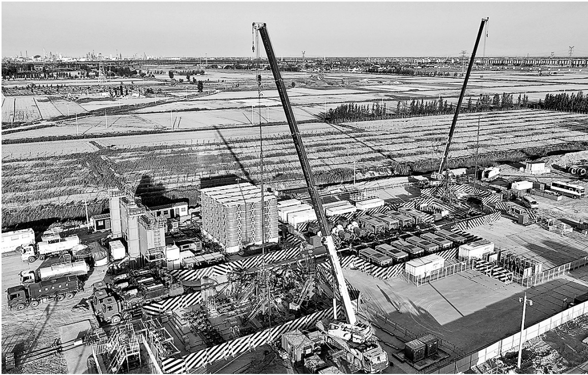
胜利油田在压裂施工中推广柔性罐
